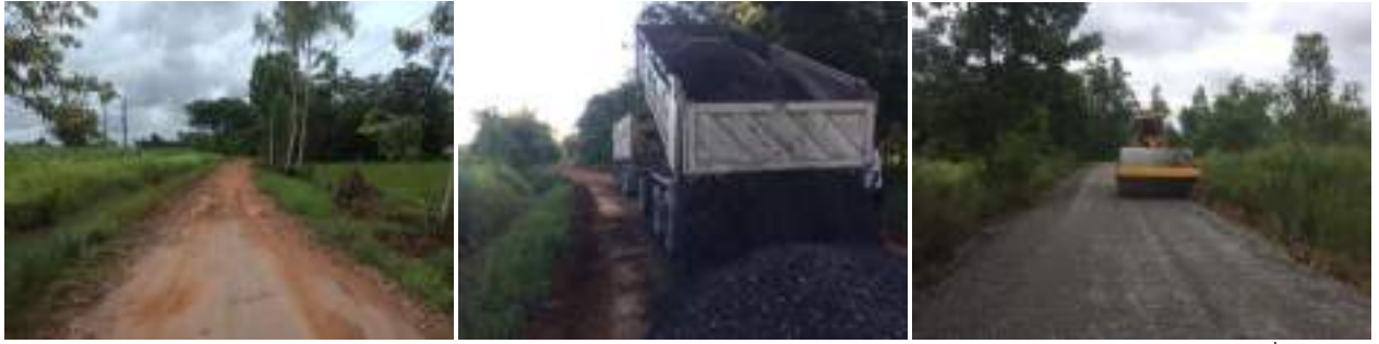
โครงการปรับปรุงถนนลูกรังโดยลงหินคลุก (บดทับ) สายบ้านนายทองคุณ-ถนนทช.นภ.3003 หมู่ที่ 13
