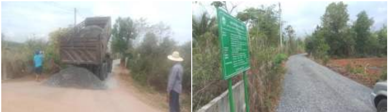
โครงการปรับปรุงถนนลูกรังโดยลงหินคลุก (บดอัดแน่น) สายโรงเรียน-หนองผักแว่น หมู่ที่ 1 บ้านลาดไต้
