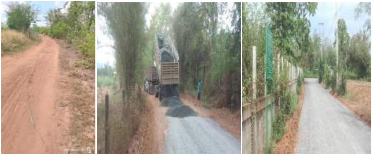
โครงการปรับปรุงถนนลูกรังโดยลงหินคลุก (บดอัดแน่น) สายโรงเรียน-หนองผักแว่น หมู่ที่ 1 บ้านลาดไต้
