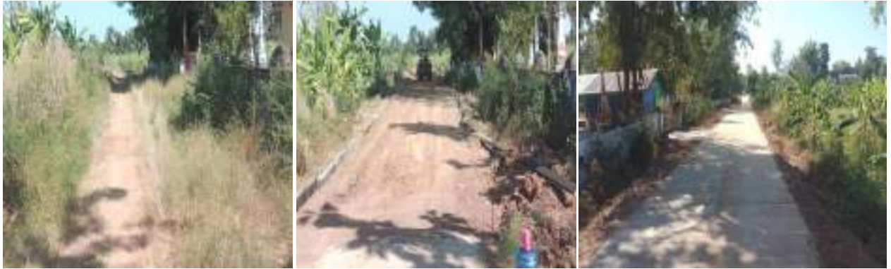
โครงการก่อสร้างถนน คสล. หมู่ที่ 13 บ้านลาดกลาง
