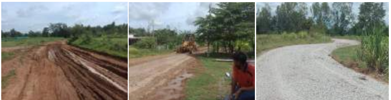
โครงการปรับปรุงถนนลูกรังโดยลงหินคลุก (บดทับ) สายวัดป่าบ้านลาด-หนองบุงคล้า บ้านลาดเหนือ ม.9
