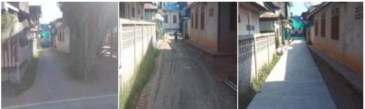
โครงการปรับปรุงถนนลูกรัง หมู่ที่ 13 บ้านลาดกลาง
