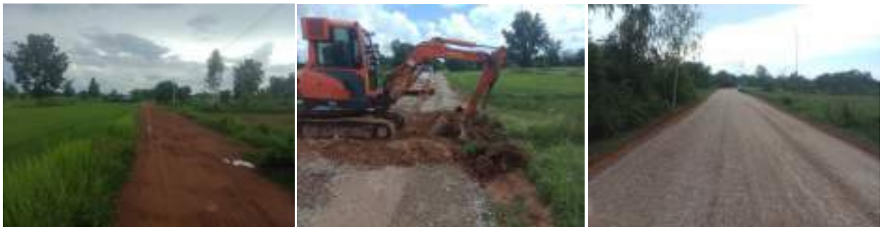
โครงการปรับปรุงถนนลูกรังโดยลงหินคลุก (บดทับ) สายตรงข้ามสหกรณ์-ลำพะเนียง บ้านลาดเหนือ ม.9
