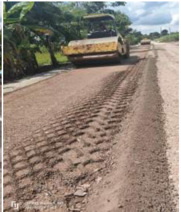
โครงการซ่อมแซมถนนลาดยางผิวแอสฟัลท์ติกคอนกรีต โดยวิธี Pavement In-place Recycling สายแยกโนนนาดี ม.๕-บ้านป่าไม้งาม ม.๖-บ้านกลางเหนือ ม.๑๐-บ้านโคกป่ากุง ม.๖
