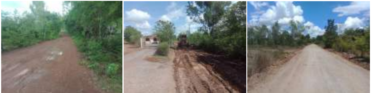
โครงการปรับปรุงถนนลูกรังโดยลงหินคลุก (บดทับ) สายประปา-ป่าช้าห้วยหอมต่าง บ้านลาดกลาง หมู่ที่ 13
