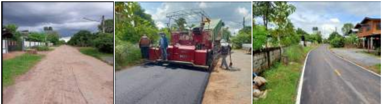
โครงการซ่อมแซมถนนลาดยางผิวแอสฟัลต์ติกคอนกรีต โดยวิธี Pavement In-place Recycling สายแยก ป่าช้าบ้านลาดเหนือ-ป่าไผ่งาม-ดินทรายอ่อน ต.หัวนา
