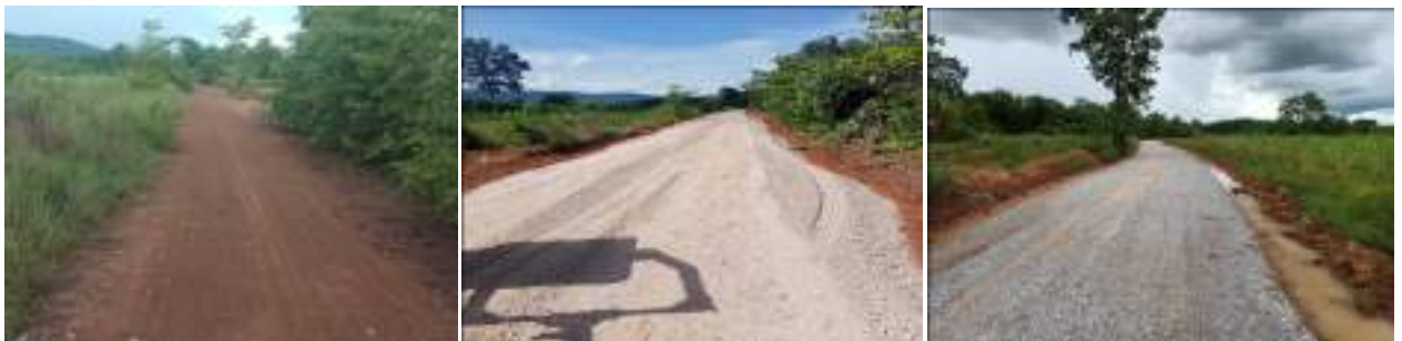
โครงการปรับปรุงถนนลูกรังโดยลงหินคลุก (บดทับ) สายวัดป่าบ้านลาด-หนองบุงคล้า บ้านลาดเหนือ ม.9
