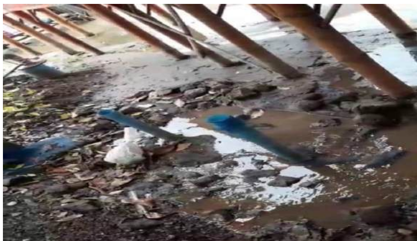
ภาพ การทำป่อซึมระบบธนาคารน้ำใต้ดินหลังบ้านเพื่อลดปัญหาน้ำเน่าเสียและท่วมขัง
