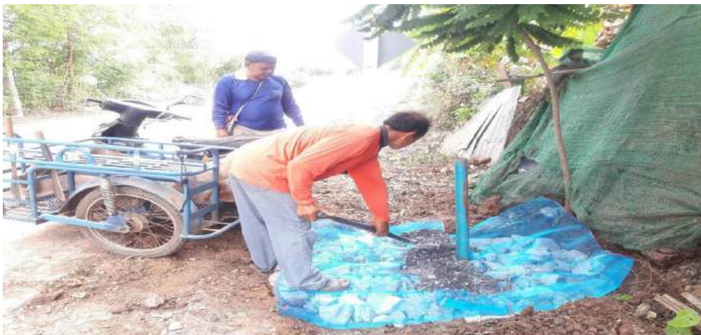
ภาพ การทำธนาคารน้ำใต้ดินพื้นที่ตำบลป่าไม้งามเพื่อลดปัญหาน้ำท่วมขังในพื้นที่สาธารณะ
