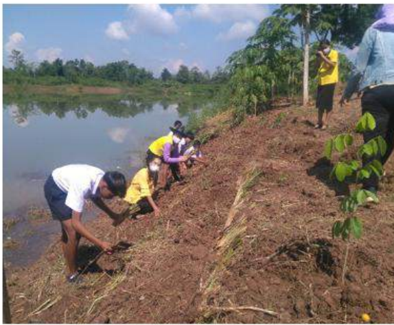
การปลูกหญ้าแฝกเพื่อป้องกันการกัดเซาะและพังทลายหน้าดิน
