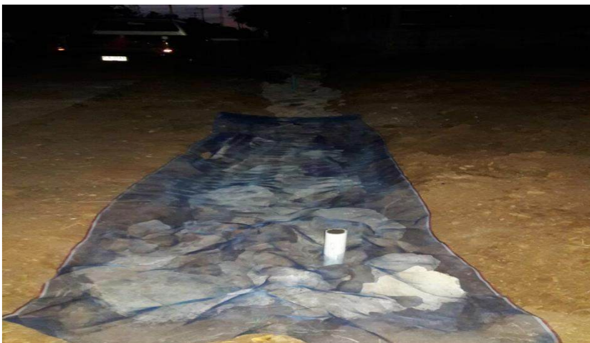
ภาพ การจัดทำระบบระบายน้ำไร้ท่อระบบธนาคารน้ำใต้ดิน
